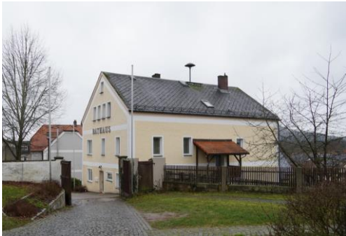
Abb. Nordfassade Rathaus; Quelle: RSP
