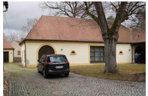
Abb. Nordtrakt; Quelle: RSP
