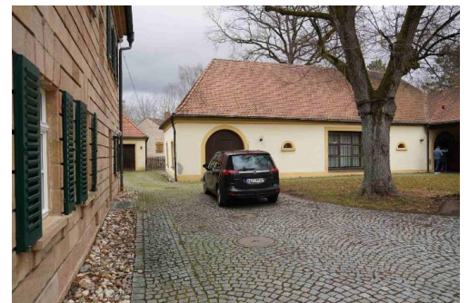
Abb. Nordtrakt; Quelle: RSP
