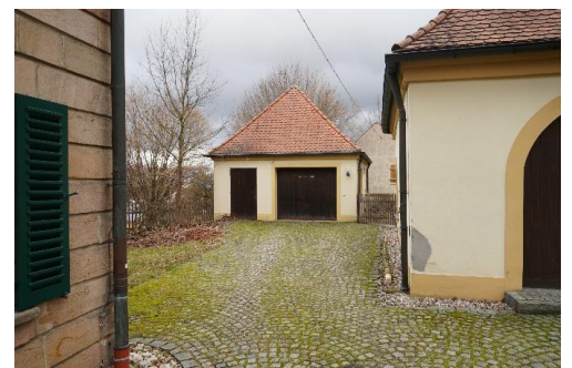
Abb. Garage Foto; Quelle: RSP
