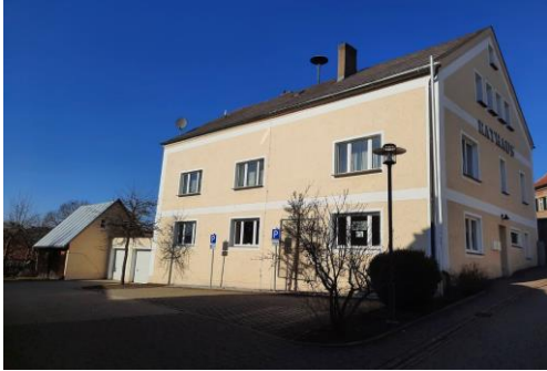
Abb. Südfassade Rathaus; Quelle: RSP
