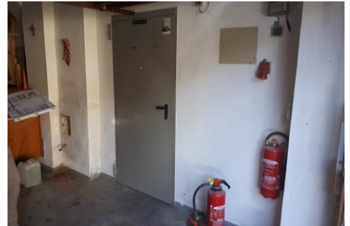
Abb. Nebenräume Südtrakt; Quelle: RSP
